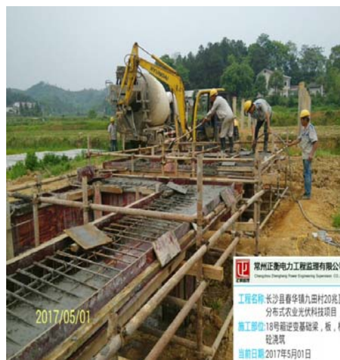
（箱、逆基础浇筑）
