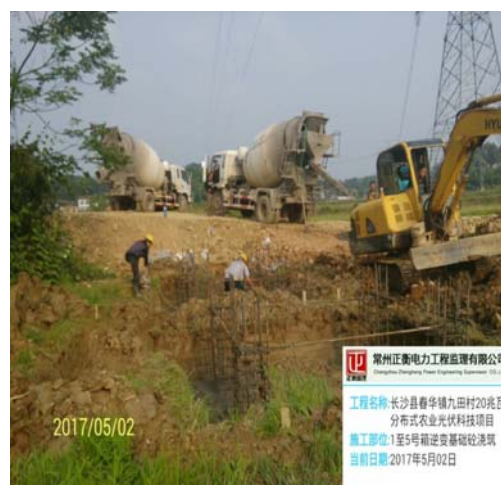
（箱、逆基础浇筑）
