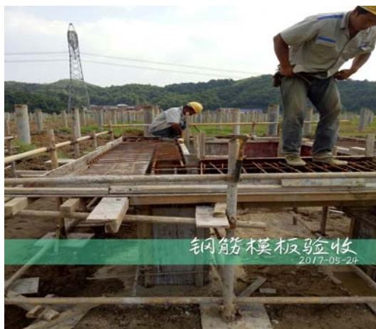
（箱变基础模板验收）
