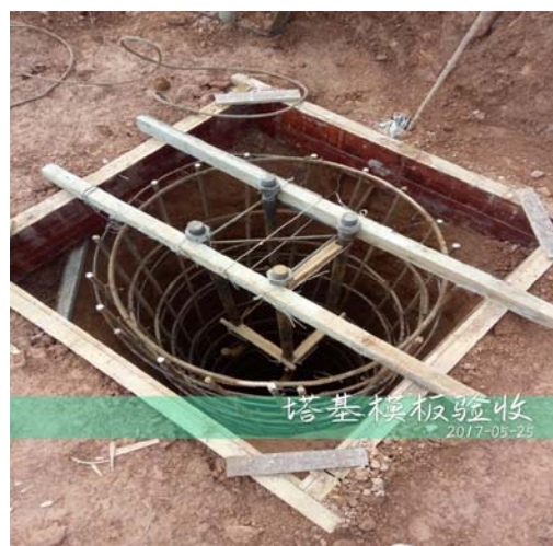
（塔基模板验收）
