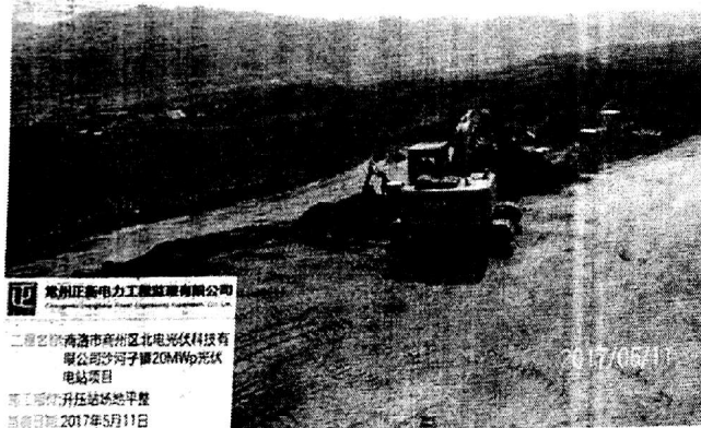
升压站土地平整
