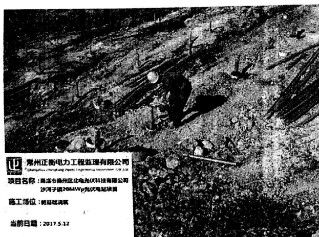
桩基础浇筑
