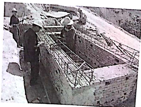
圆梁钢筋绑扎
