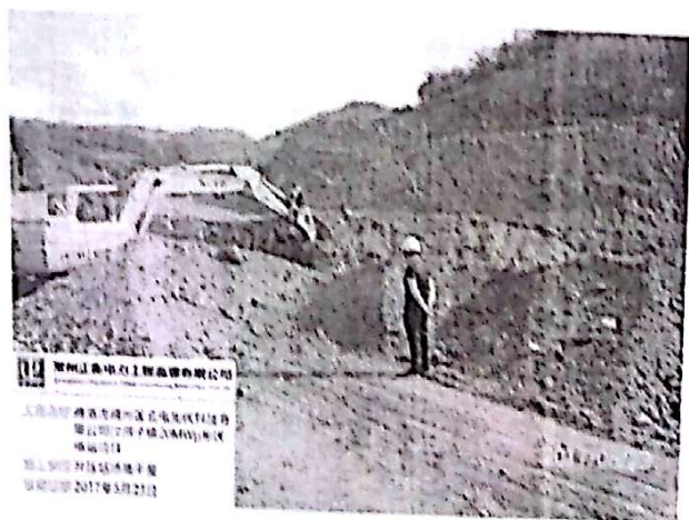
升压站土地平整
