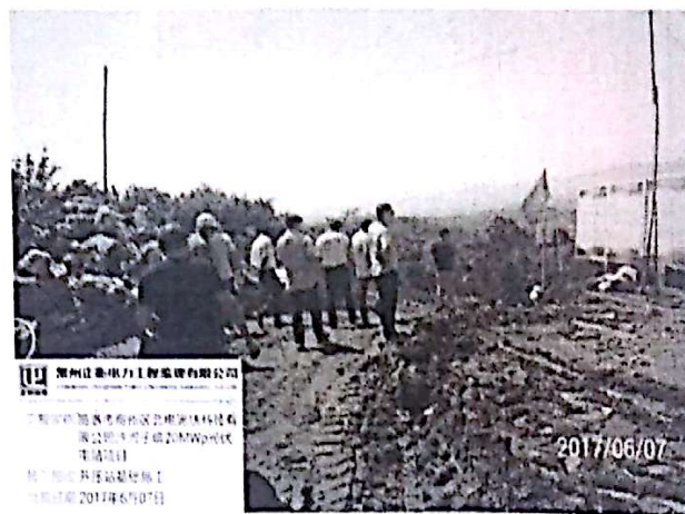
升压站基础施工
