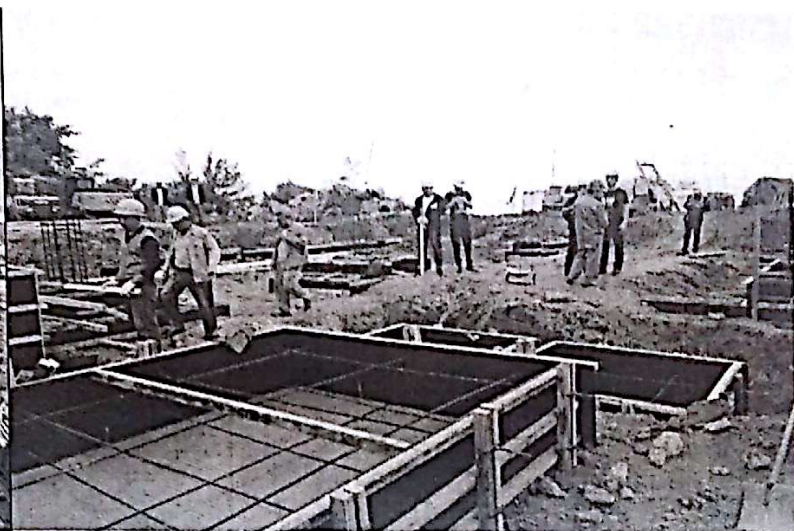
生活区施工进度
