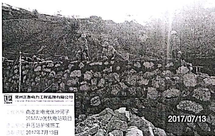
升压站护坡施工
