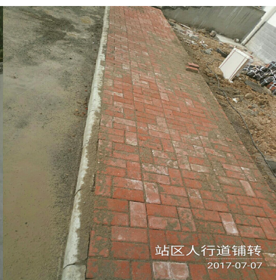
消防水池顶部砌砖 2017-07-06
