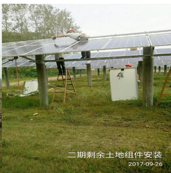
二期剩余土地组件安装 2017-09-26
