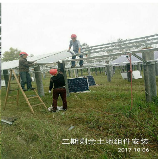
二期剩余土地组件安装 2017-10-06
