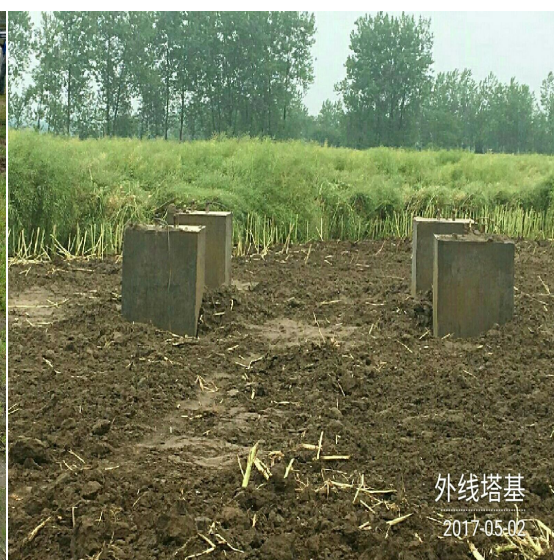
箱逆变基础桩检查 2017-05-02
