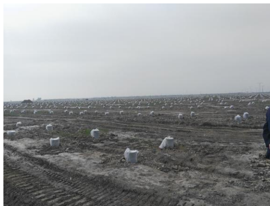
灌注桩完成区域
