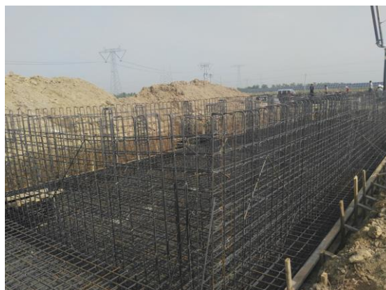
一次预制舱底板、板墙钢筋制作
