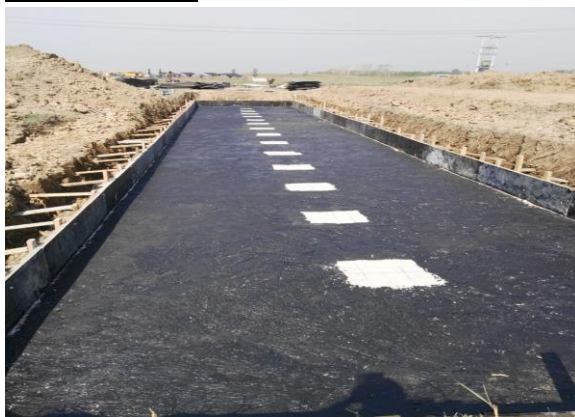
二次预制舱垫层防腐
