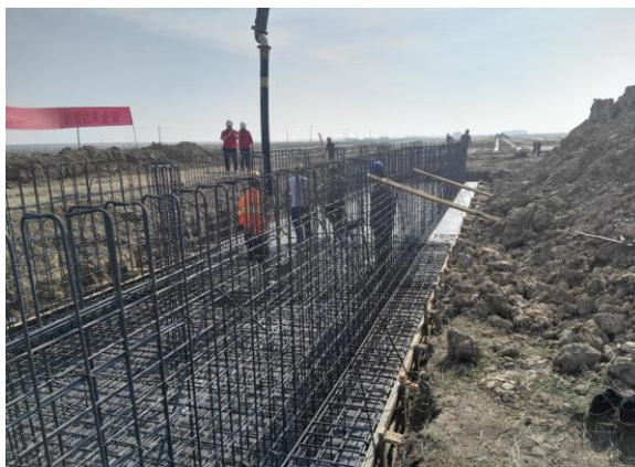
二次预制舱底板浇筑
