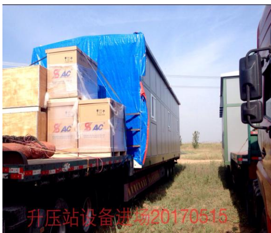
升压站各预制舱进场。
