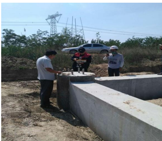
外线基础桩检测
