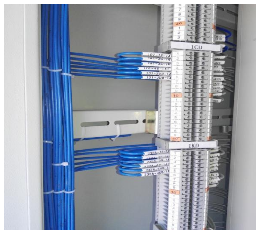
二次电缆敷设连接
