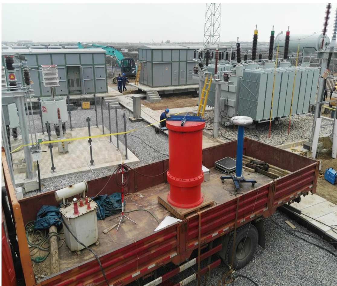
升压站耐压测试、接地连续性测试
