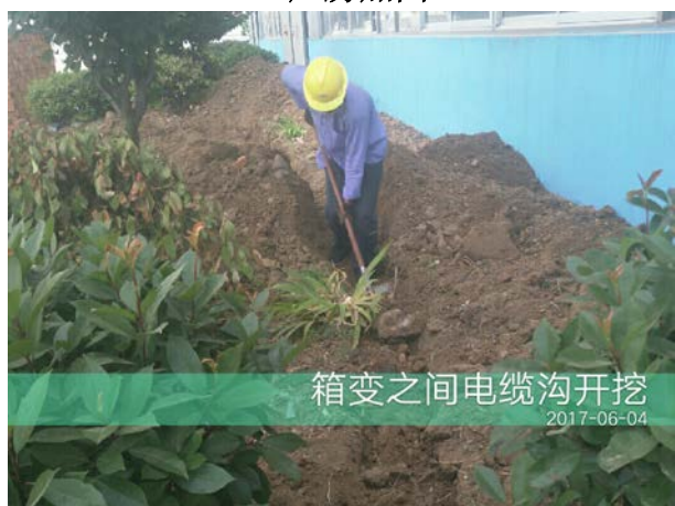
箱变之间电缆沟开挖
