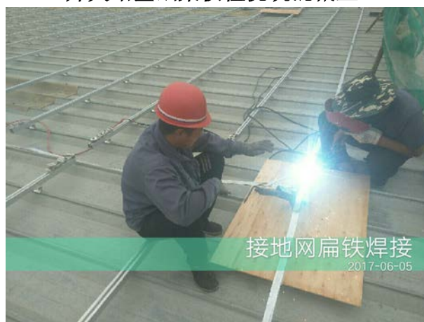
光伏区接地网扁铁焊接
