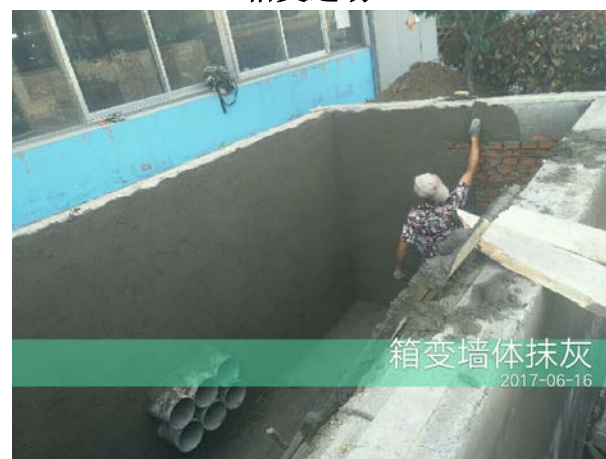
箱变墙体抹灰
