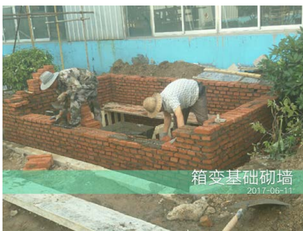
箱变基础砌墙
