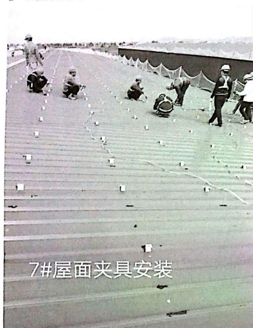
1—7#屋顶夹具安装
