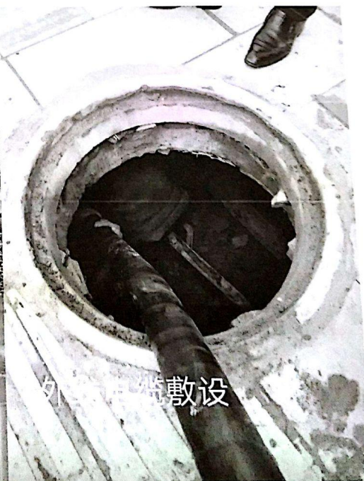
外线电缆敷设
