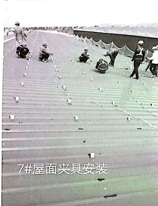
1—7#屋顶夹具安装
