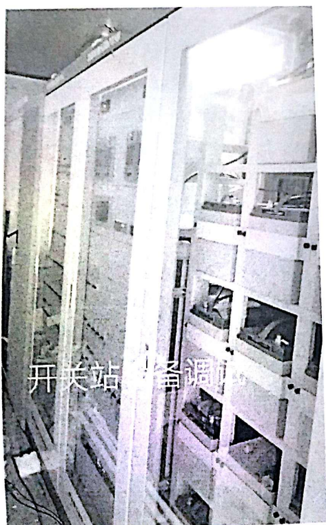
开关站设备调试
