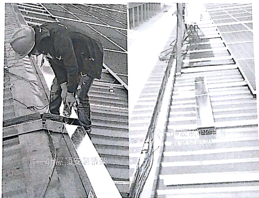
2—6#屋顶 4 平方直流电缆敷设
