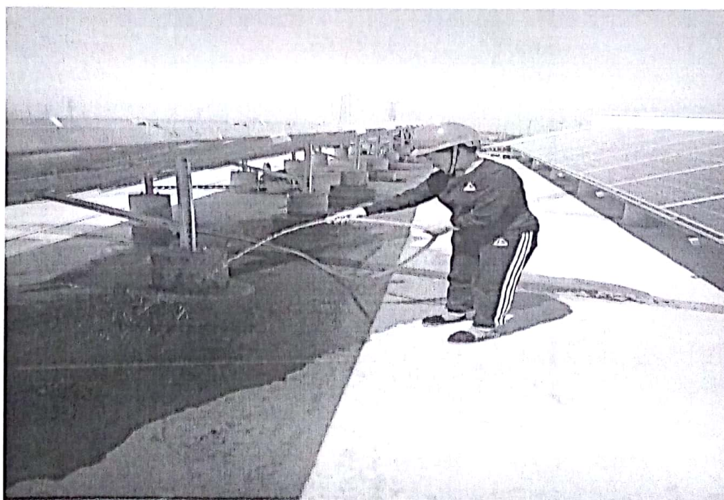
支墩浇注后养护
