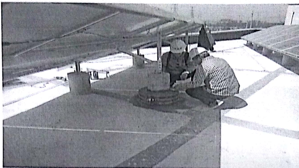
监理检查支墩浇注
