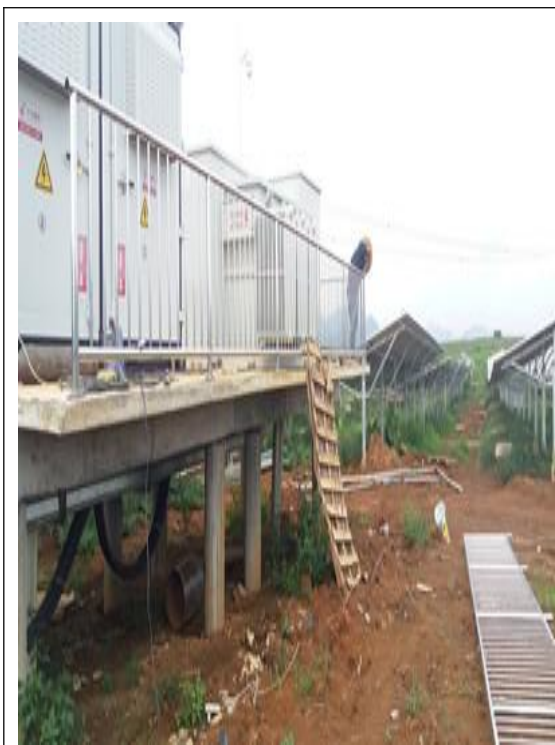
31 区箱逆变平台栏杆制作
