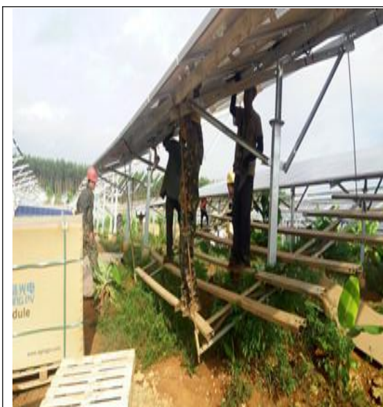
32 区光伏板组件安装
