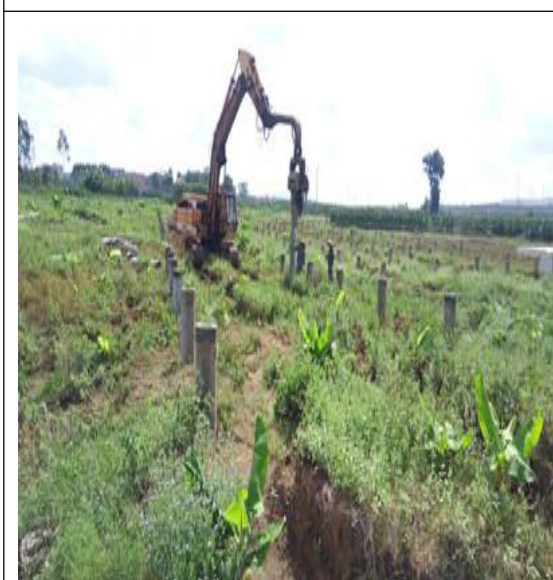
44 区预制桩打桩
