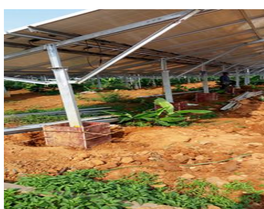
30 区光伏板组件安装
