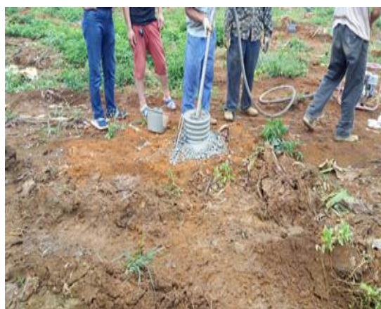
12 区浇筑桩基基础砼
