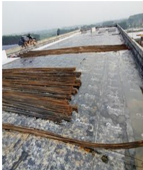
综合楼屋顶防水施工完成
