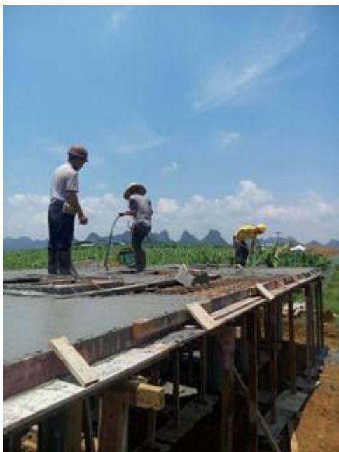
19 区箱逆变基础平台浇筑
