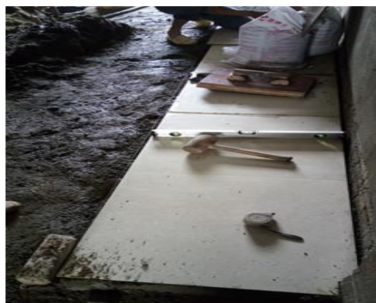
综合楼室内地砖铺设
