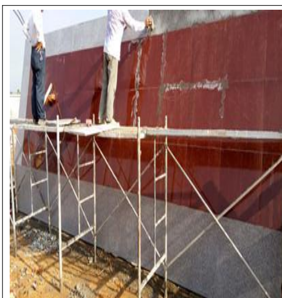
综合楼大门墙体贴砖
