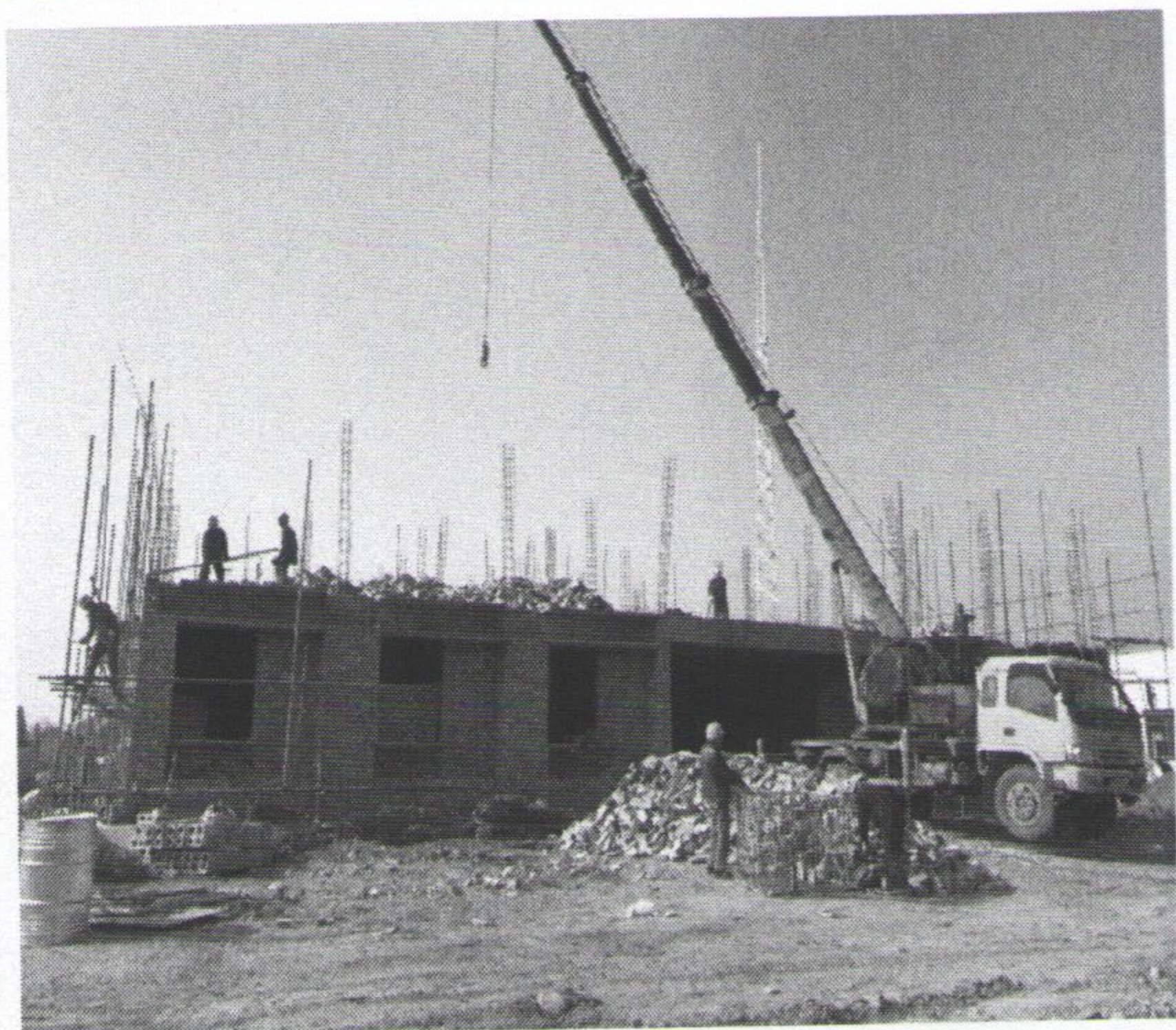
综合楼脚手架搭设
