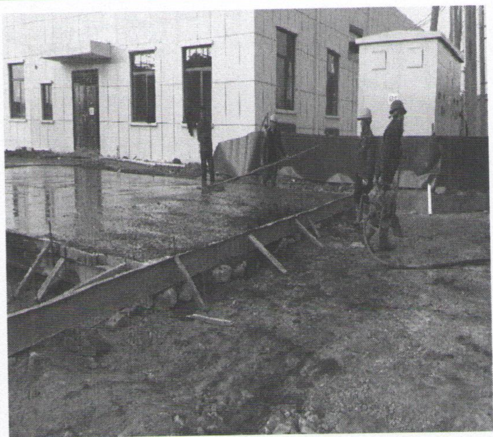
开关站道路浇筑
