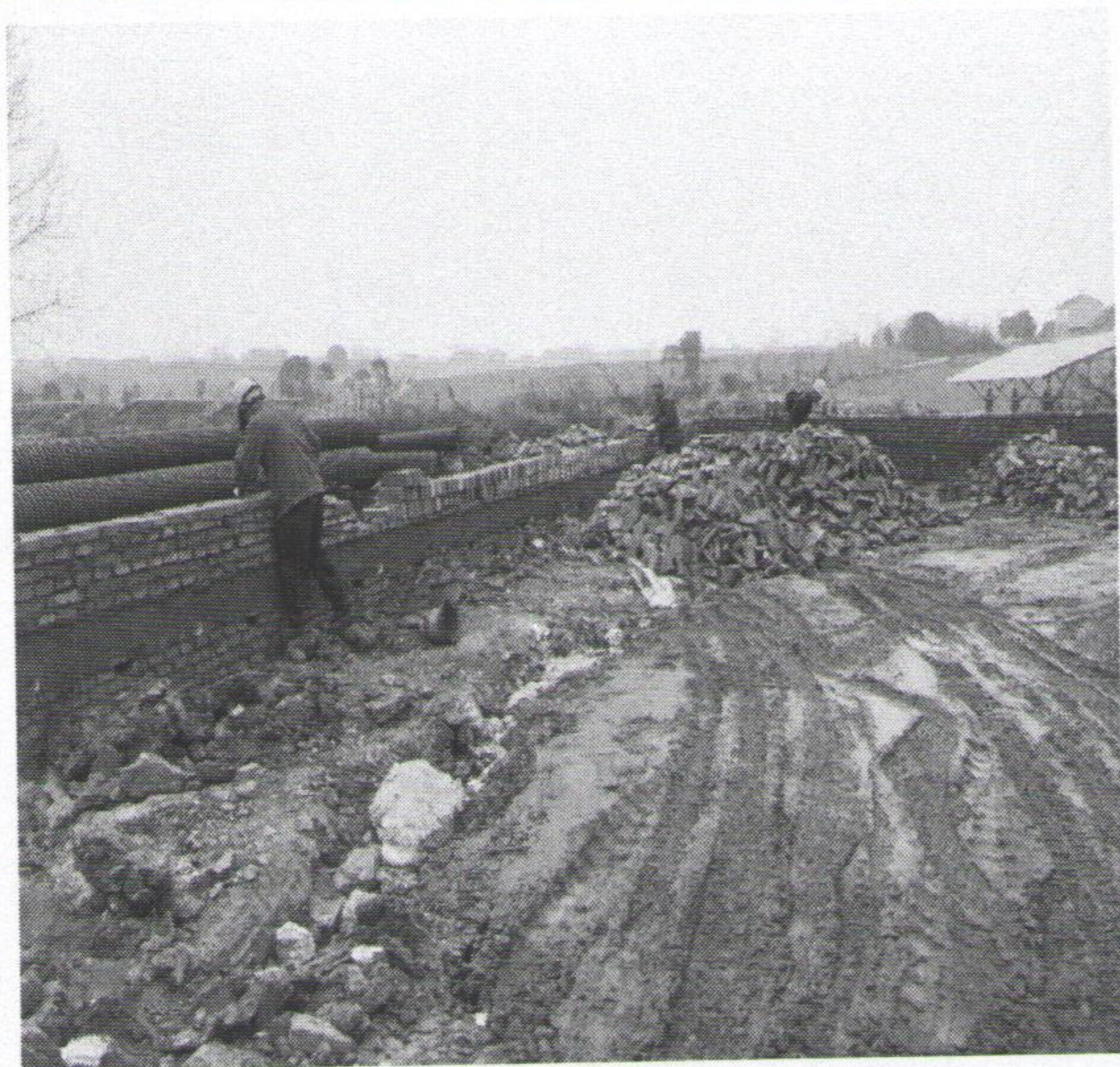
开关站围墙砌筑
