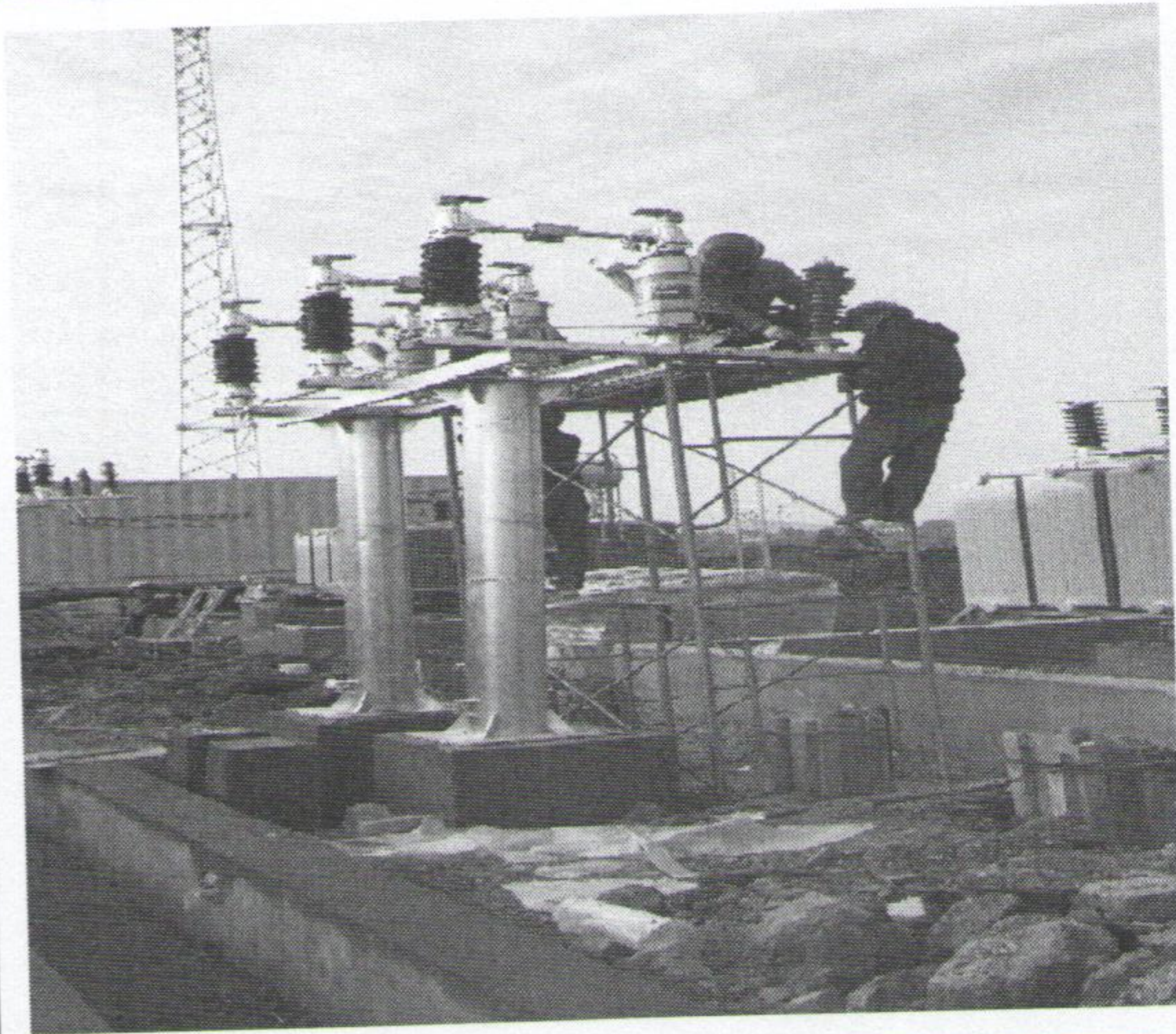
SVG 隔离刀闸安装
