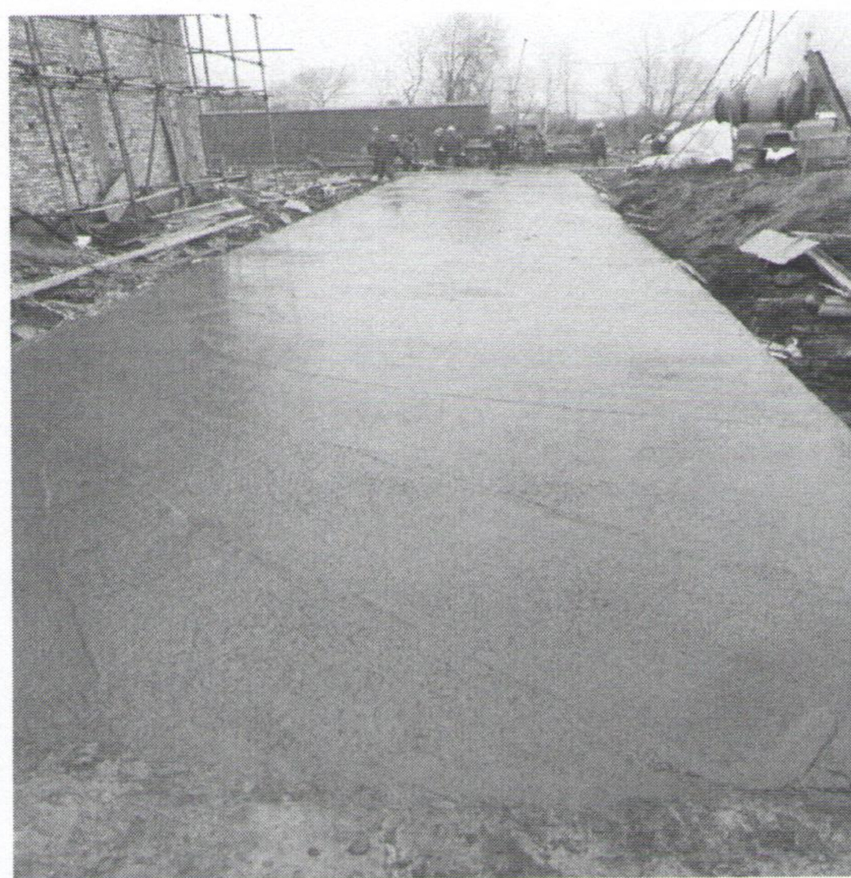
开关站路面浇筑
