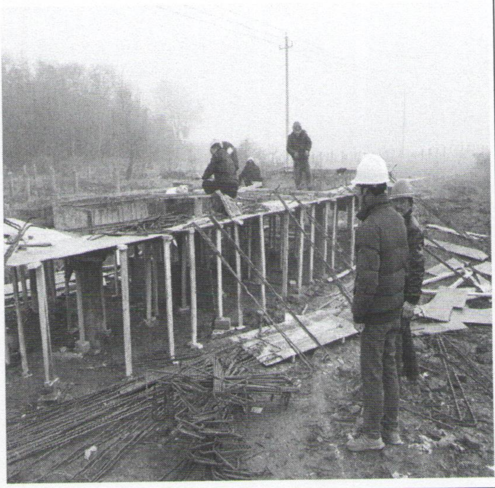
箱逆变基础钢筋绑扎
