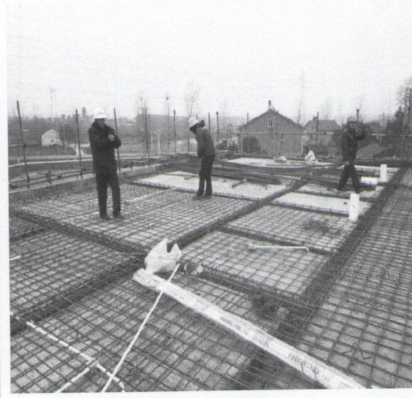
综合楼二楼顶板钢筋绑扎
