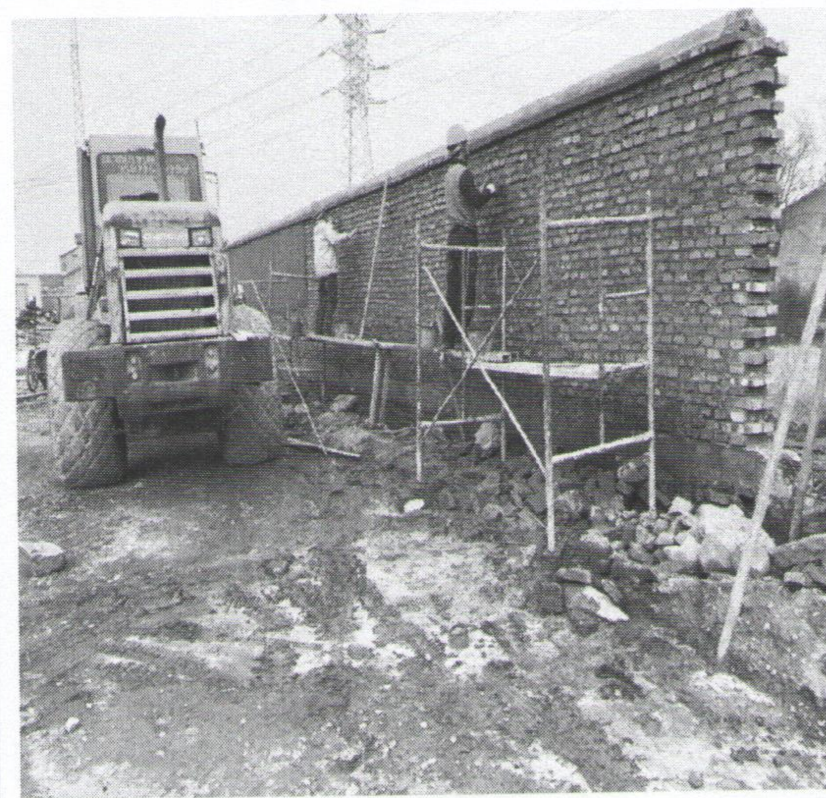
开关站围墙粉刷
