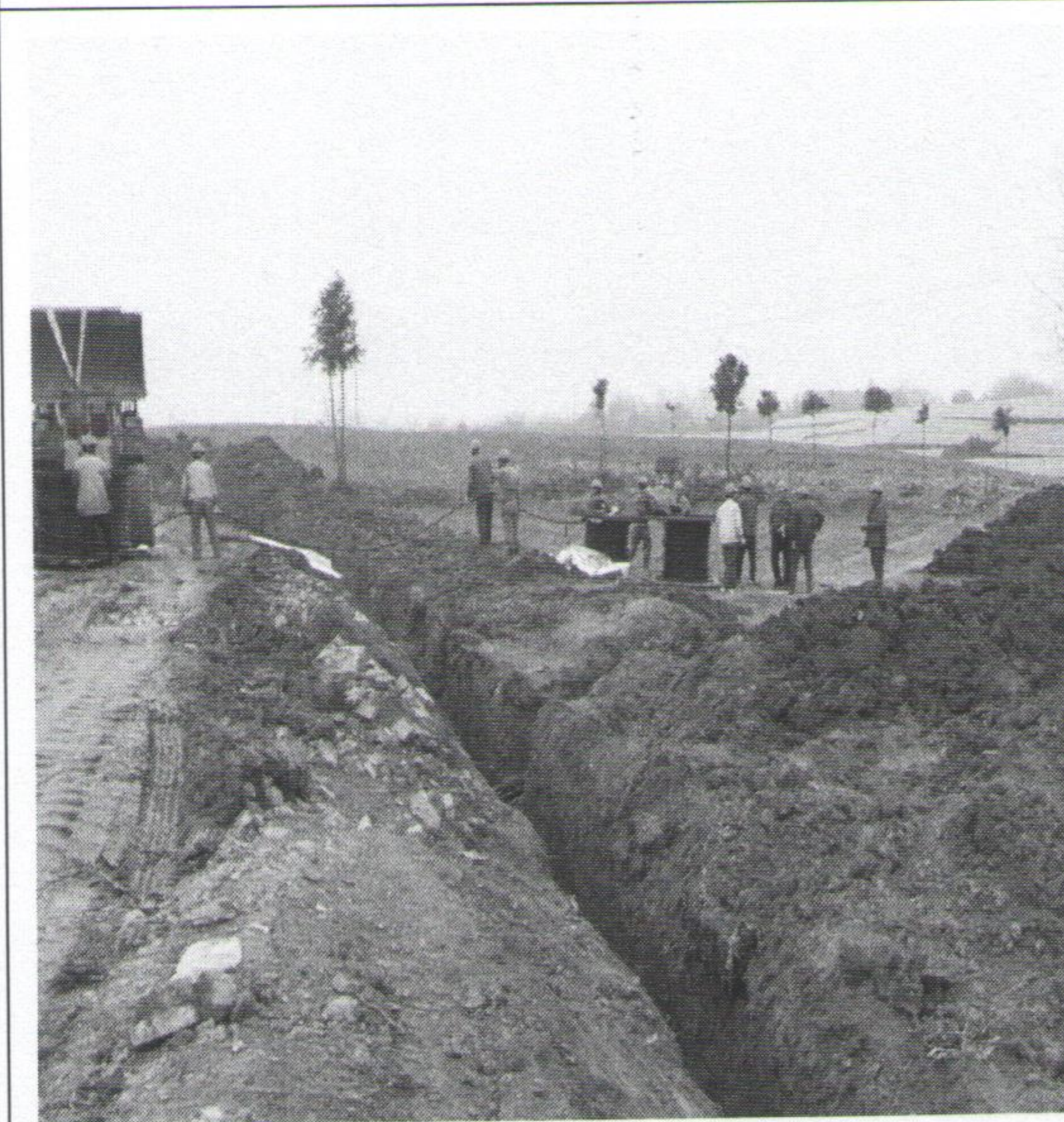
高压电缆敷设
