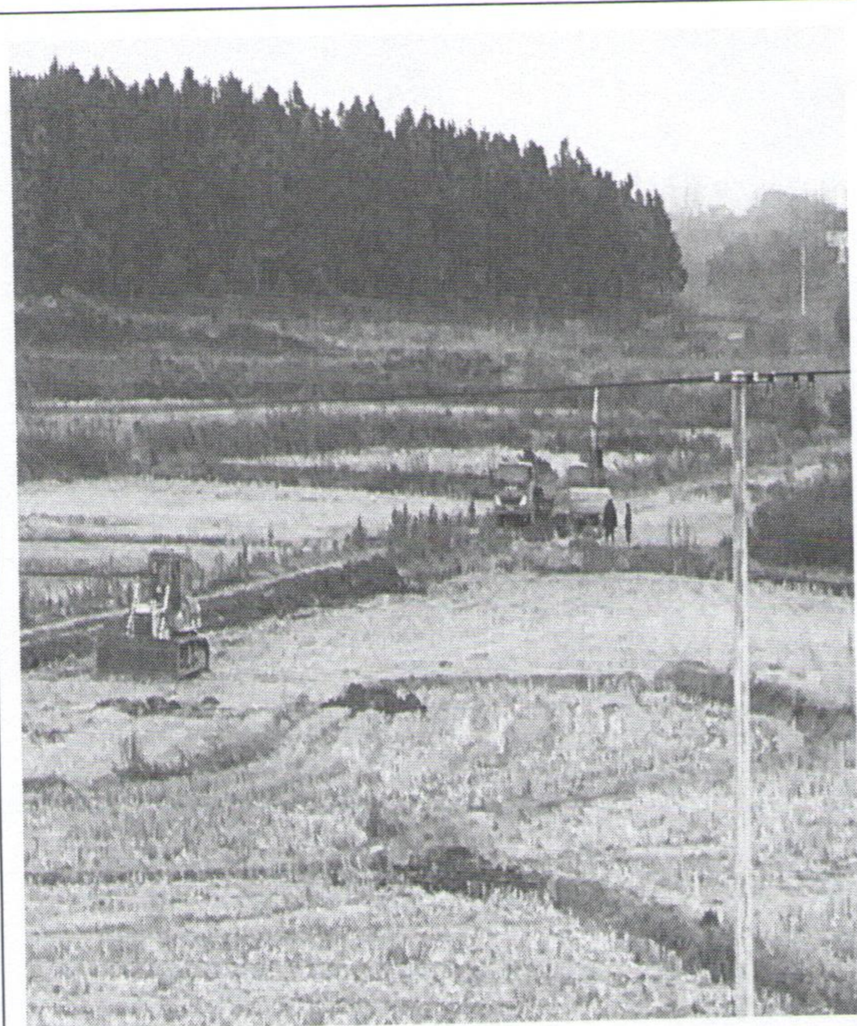
光伏区道路修筑
