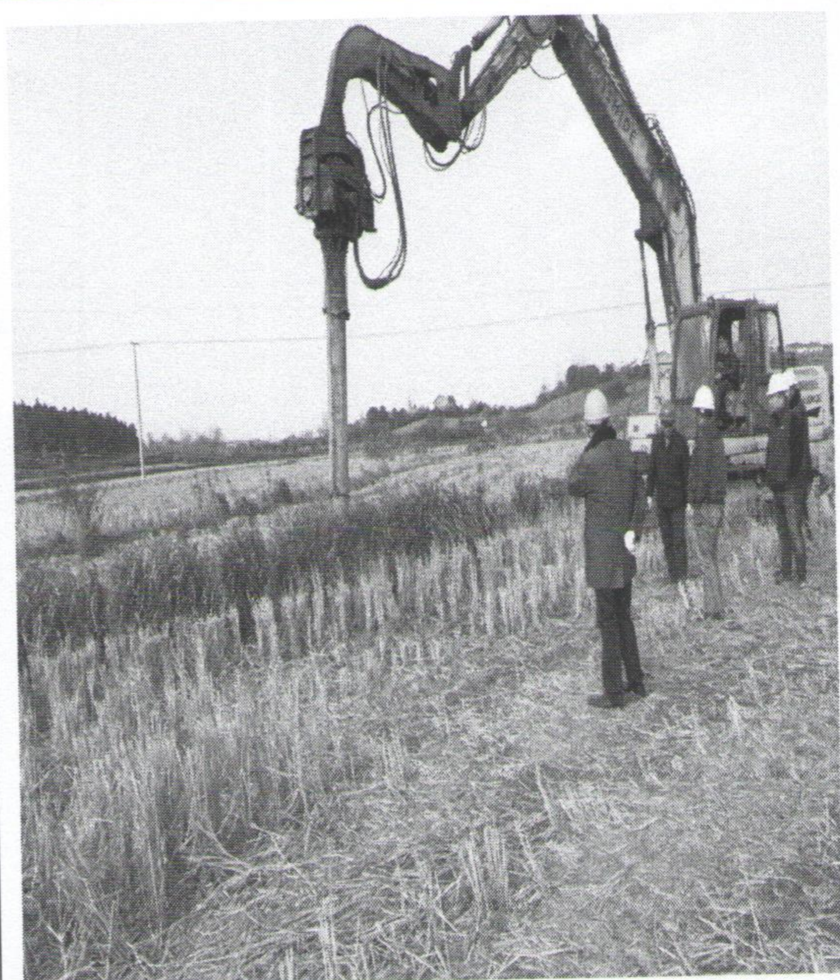
光伏区试桩施工
