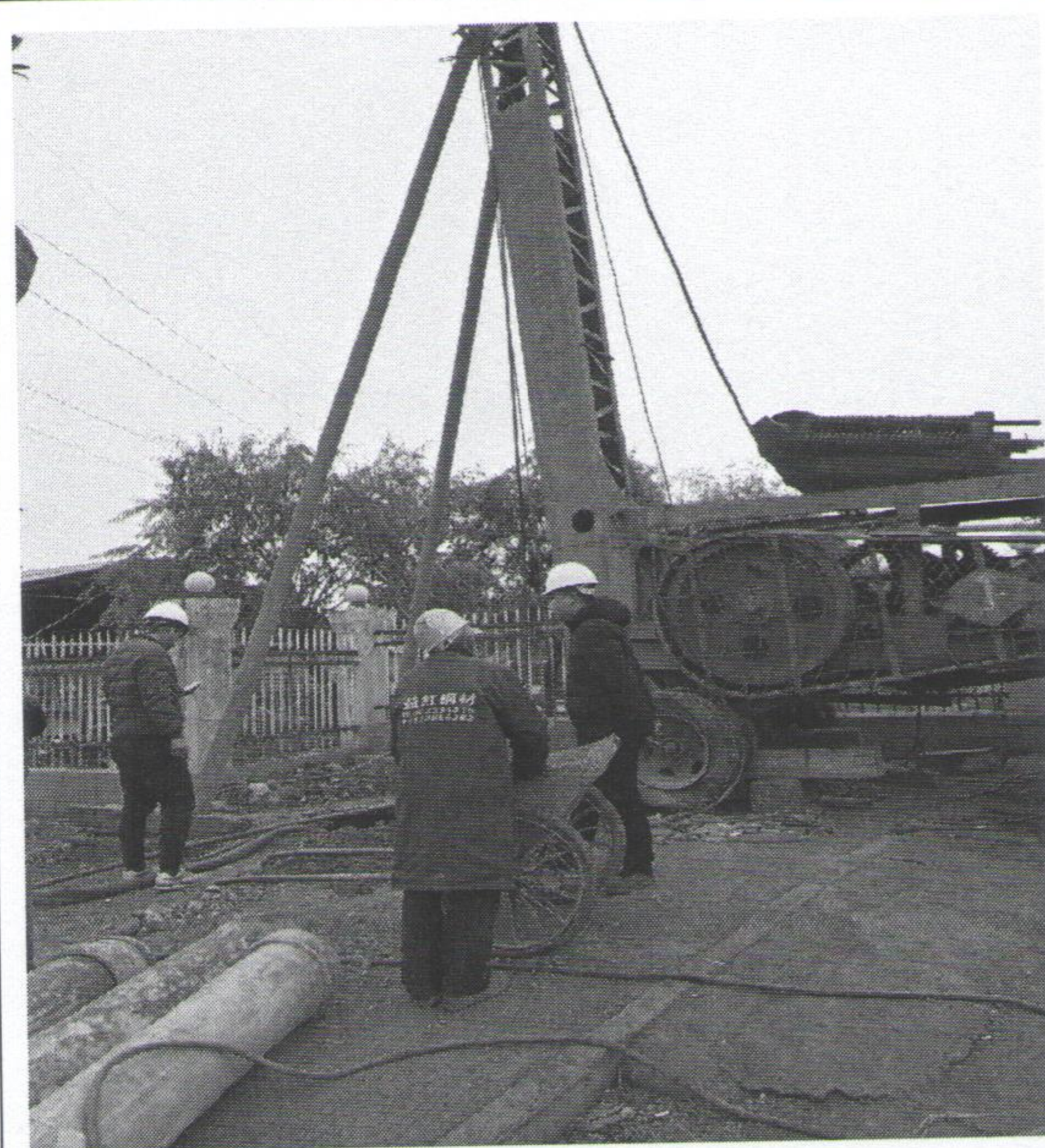
G37 基础开挖
