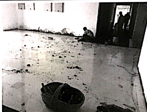
综合楼一楼大厅地砖铺设
