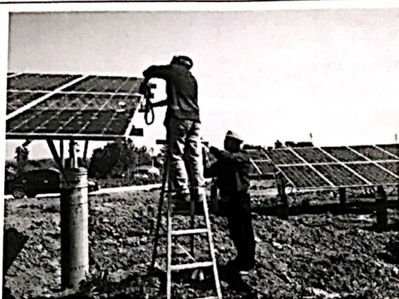
23 区边压块更换施工
