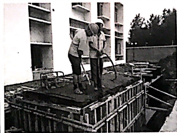
污水池基础混凝土浇筑
