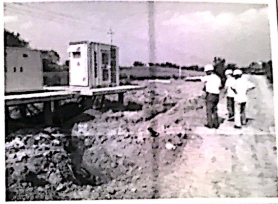
检查现场情况
