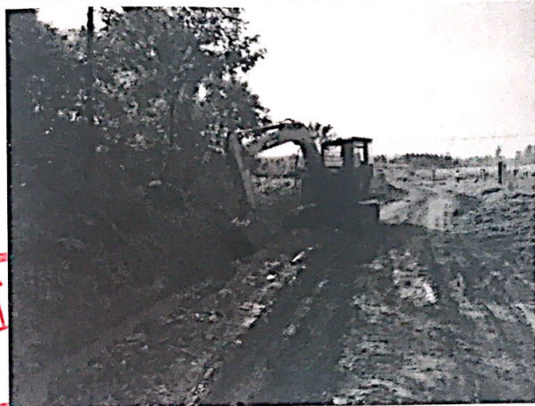
道路排水沟清理
