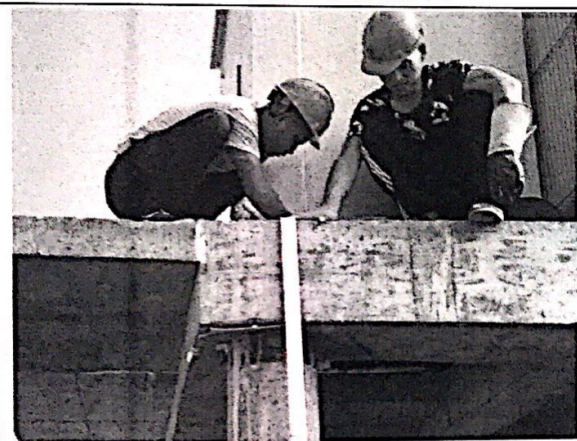
32#箱逆变平台接地扁铁焊接
