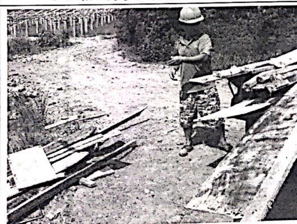
33#箱逆变平台模具拆除
