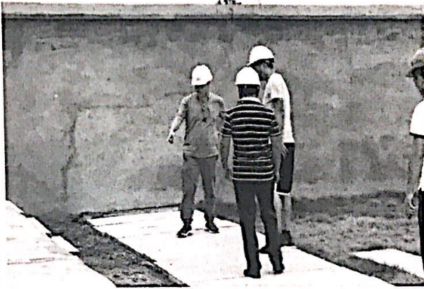
检查现场情况
