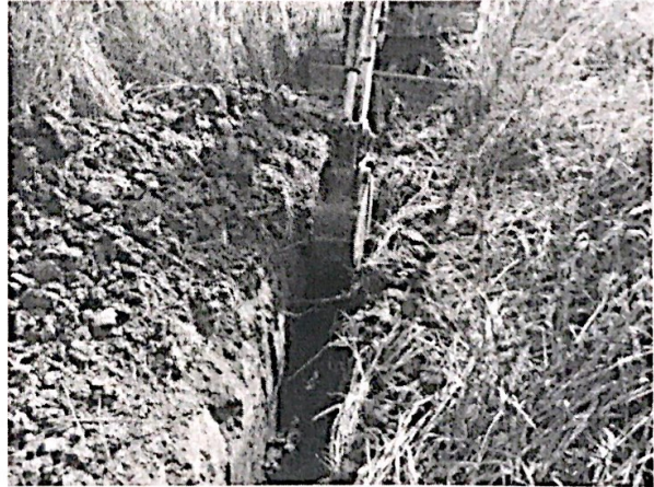
29 区接地沟开挖
