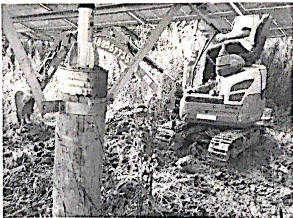
16 区电缆沟回填
