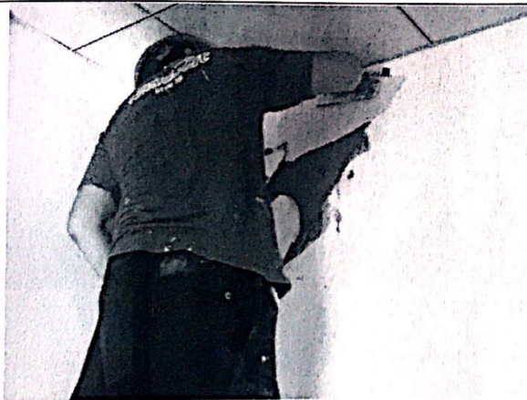
综合楼墙面修补
