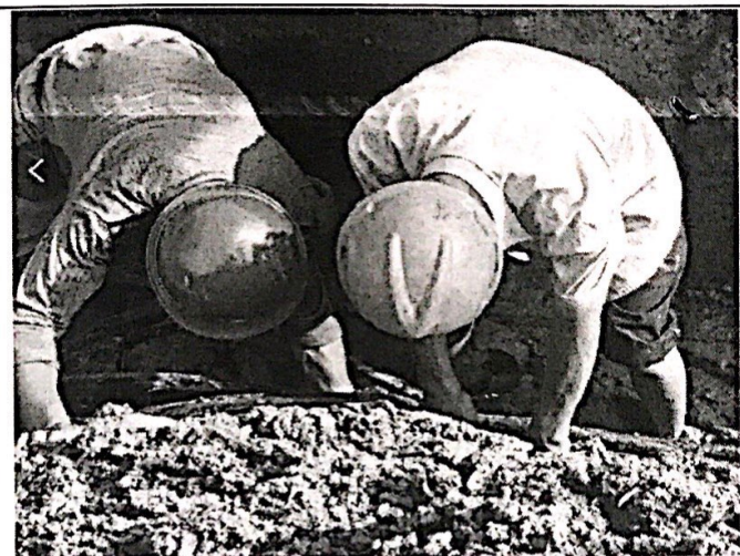
32 区直流电缆敷设
