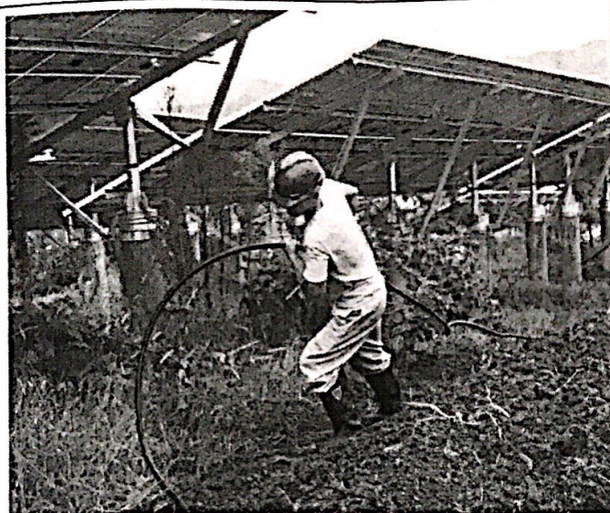
30 区直流电缆敷设
