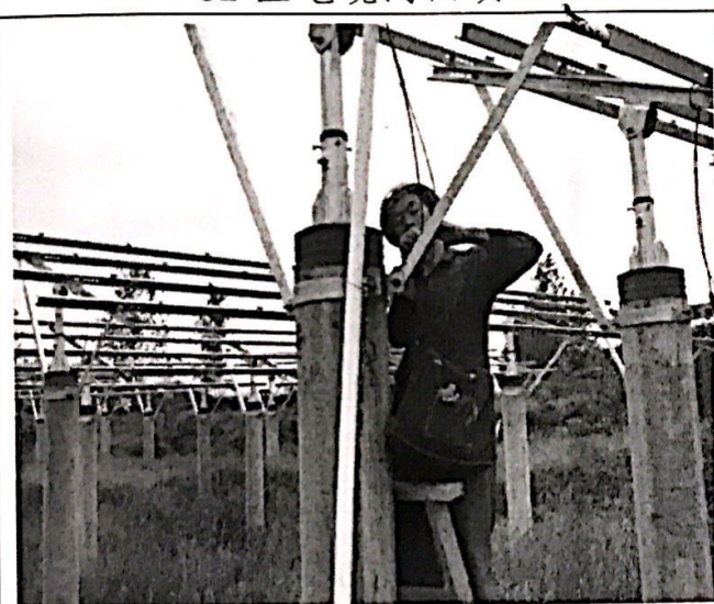
32 区光伏电缆 MC4 插头制作
