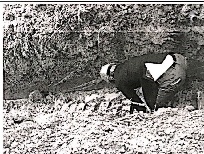
32 区电缆沟铺设盖砖
