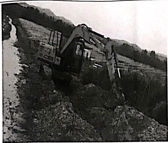
32 区电缆沟回填
