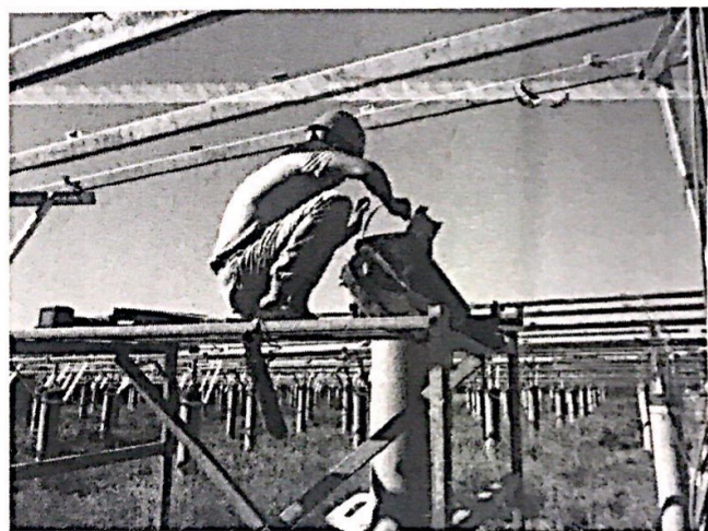
31 区汇流箱固定架安装
