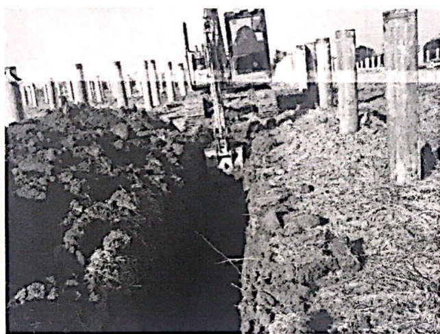
39 区电缆沟开挖
