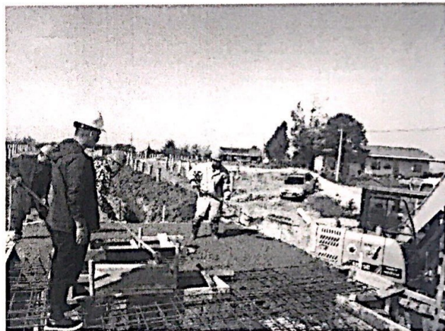
39 箱逆变平台浇筑
