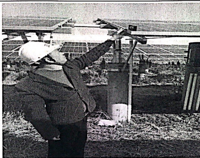
检查组件安装
