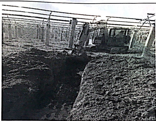
33 区电缆够施工
