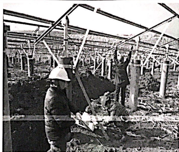
38 区光伏电缆敷设
