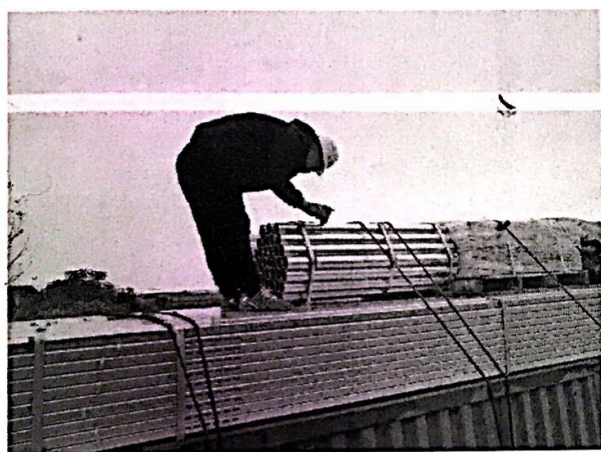
抽查支架材料镀锌层
