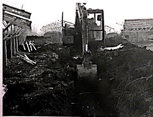
40 区接地沟开挖
