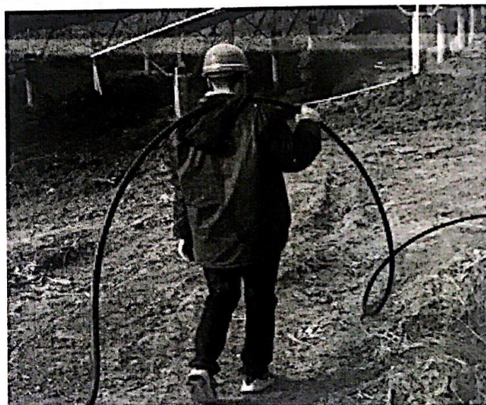
34 区直流电缆敷设
