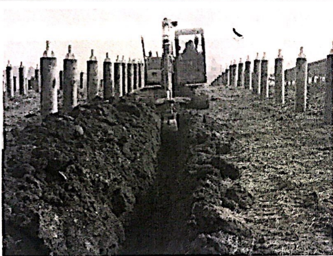
9 区电缆沟开挖
