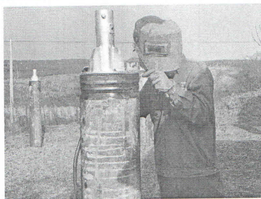
28 区支架基座施工
