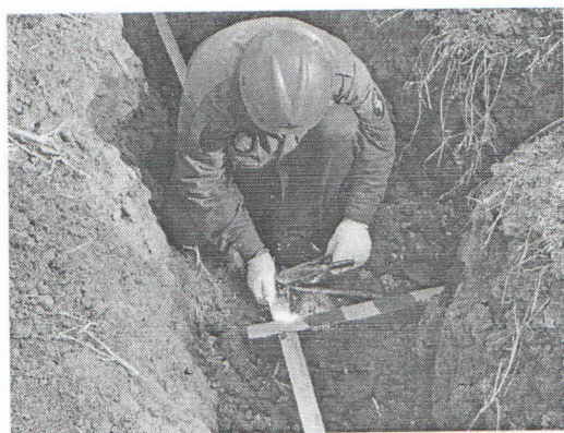
39 区接地扁铁焊接
