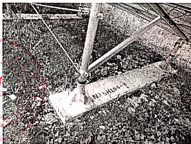
光伏 35 区组串编号施工
