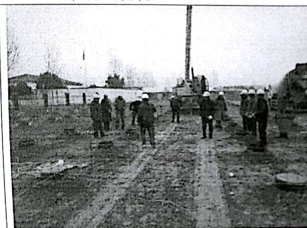
一标浇筑现场
