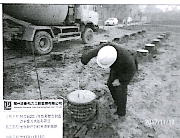
桩基础浇筑验收
