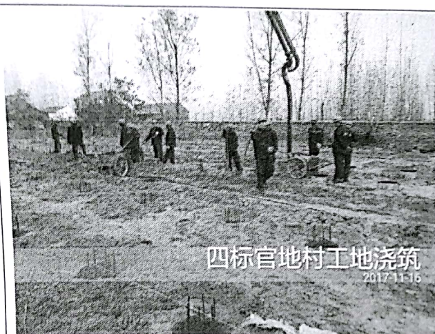
桩基础浇筑
