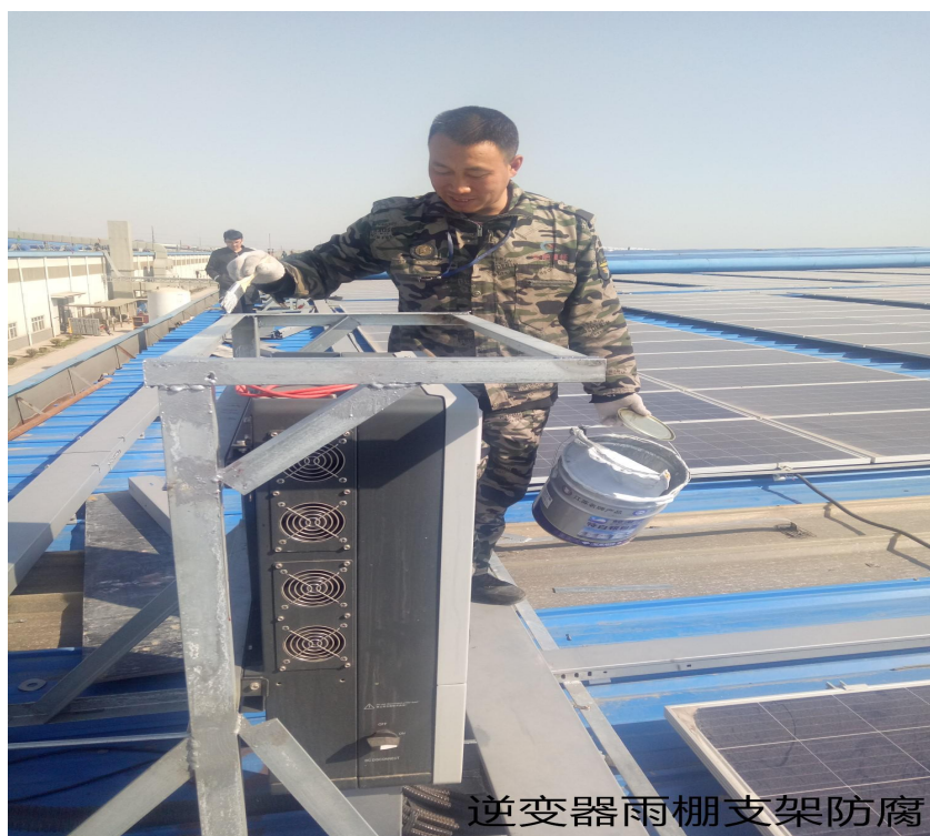
逆变器雨棚支架防腐
