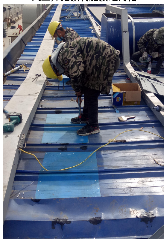
修补屋面破损处
