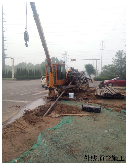
外线顶管穿线施工
