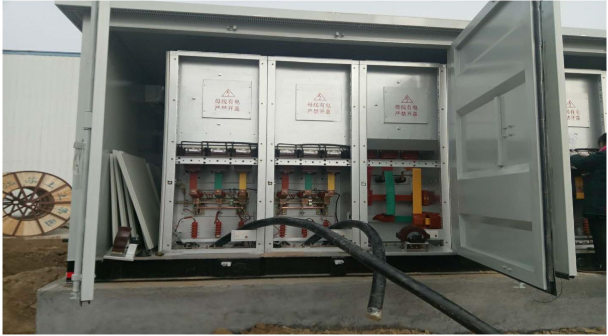
2017.12.30 一次设备预制舱内电缆头制作
