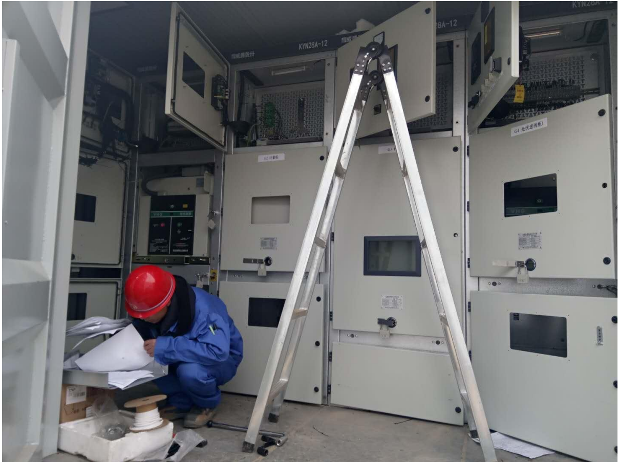
2018.01.03 一次设备预制舱内接线
