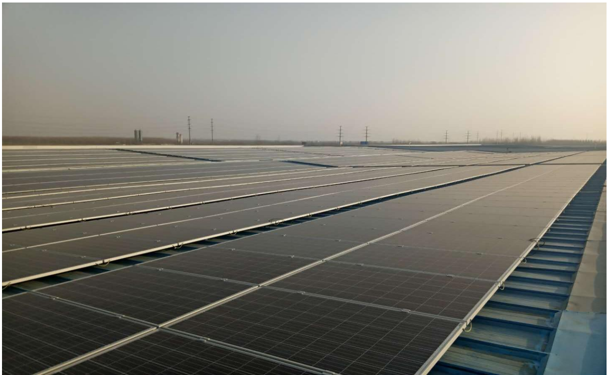
2017.12.31 八号厂房屋面组件安装完成
