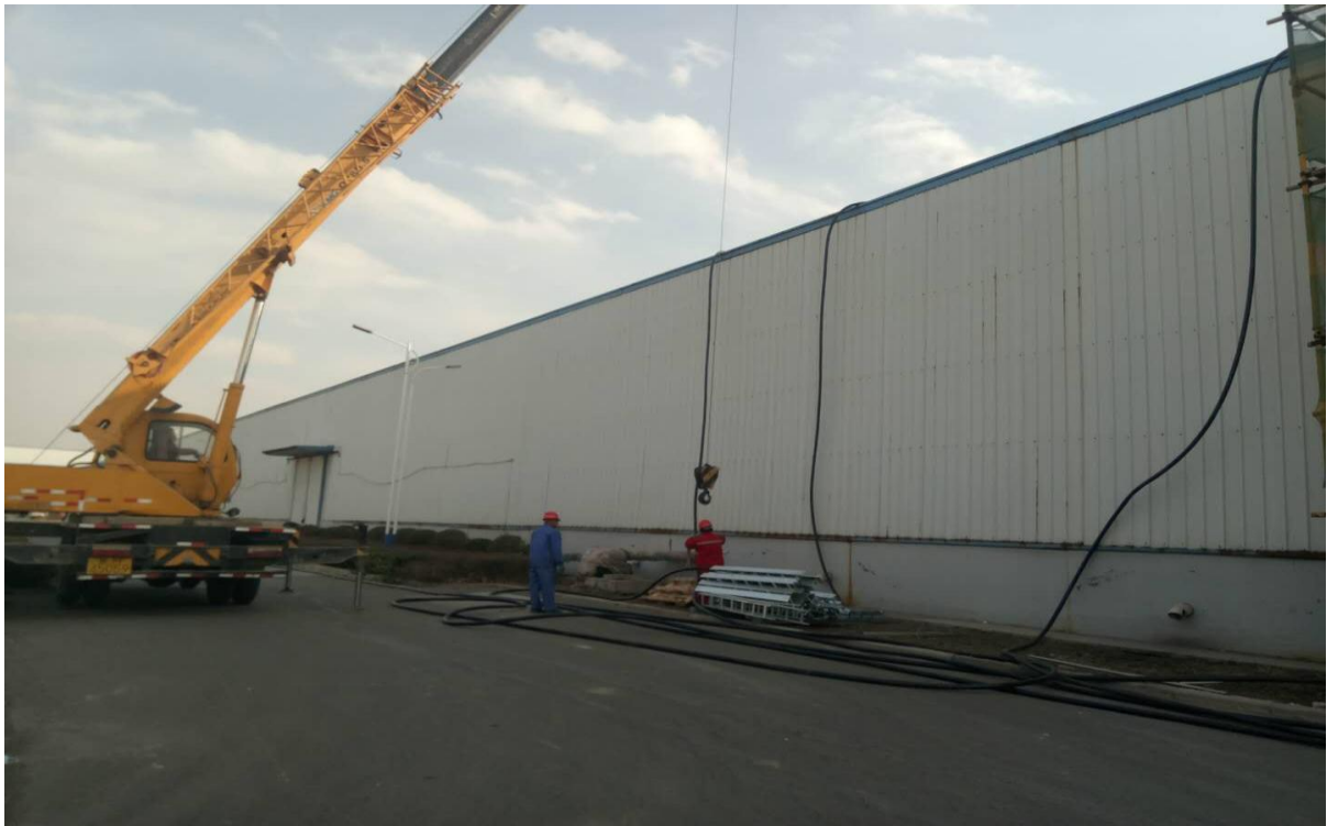
2018.01.09 屋面电缆敷设
