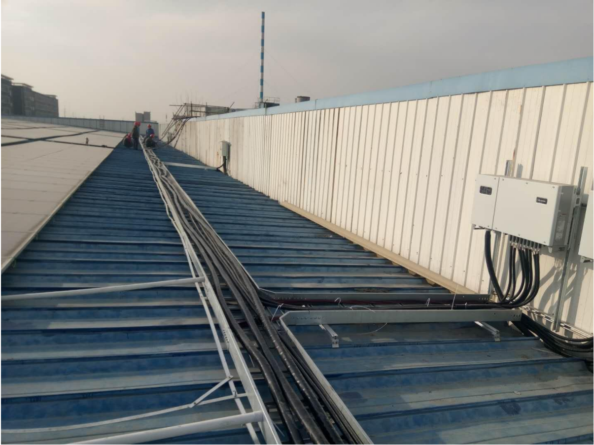
2018.01.09 屋面电缆敷设
