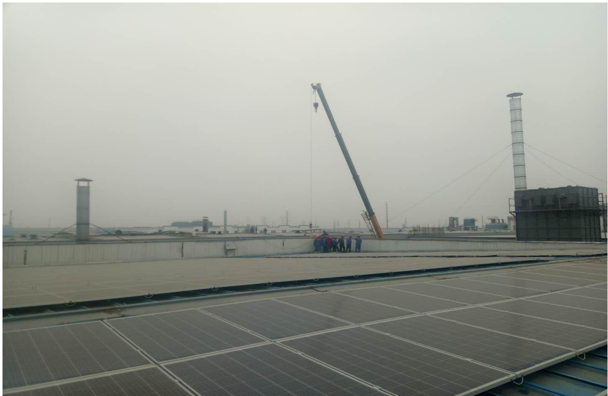
2018.01.06 屋面电缆敷设
