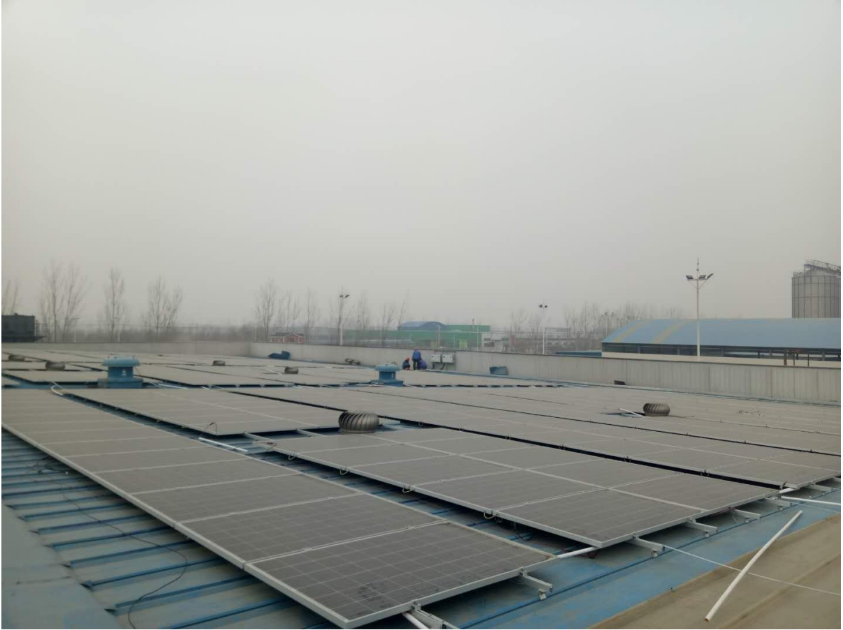
2018.01.18 屋面 4 平方线接线、穿管
