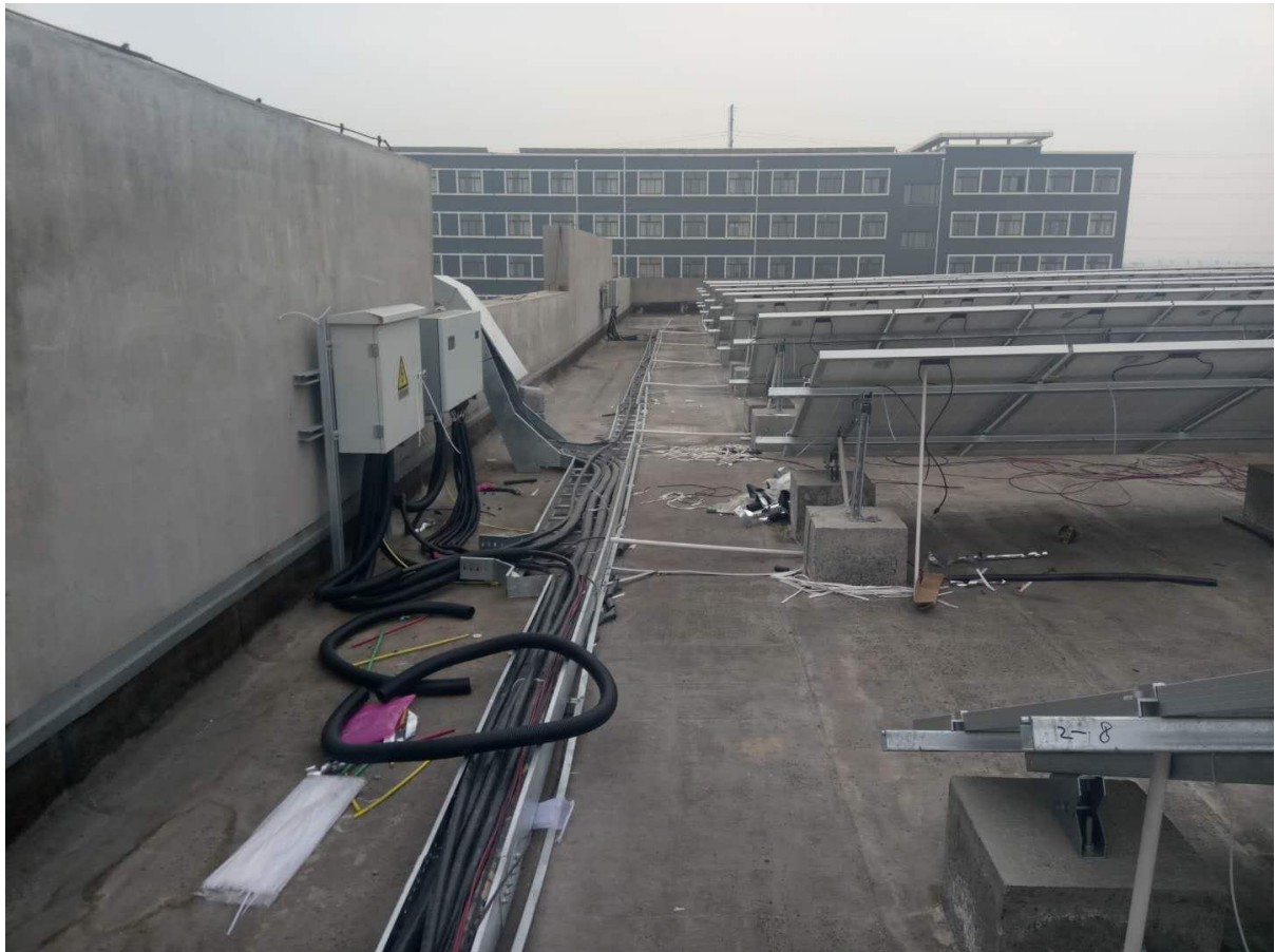
2018.01.15 汇流箱、逆变器接线
