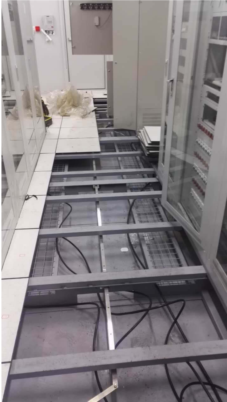
图 3 预制舱内放线
