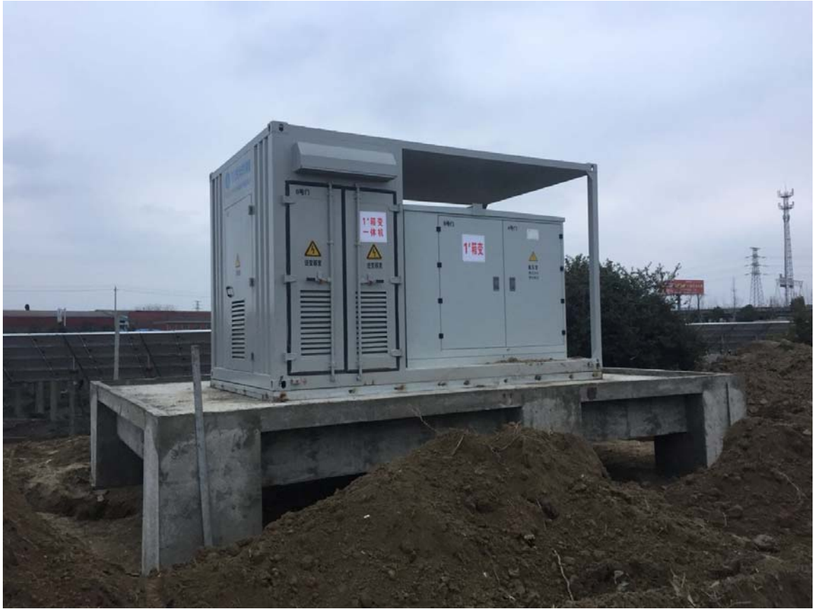
图 2 南沈灶箱逆变就位
