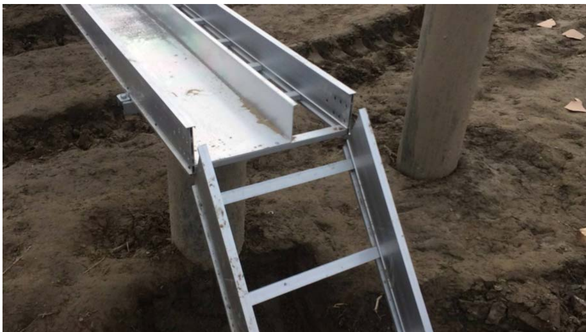
图 1 南沈灶桥架安装
