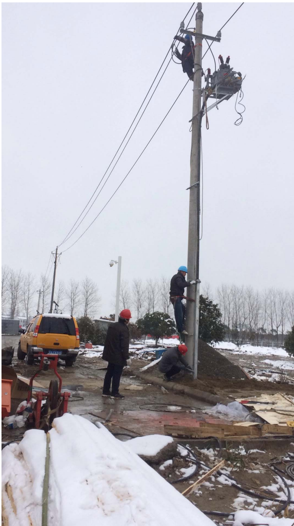
图 4 10kV 并网线路施工
